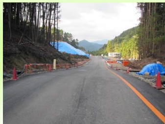
①工事用道路舗装1
