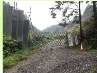
③下流ゲート仮囲設置
