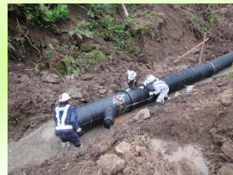
④地下集排水管設置
