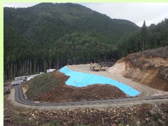
②工事用道路2
