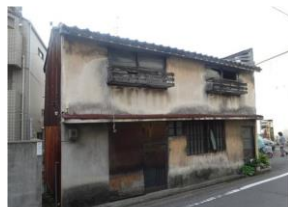
③景観を損なっている
