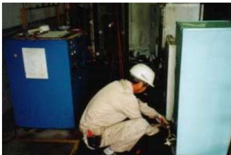
安佐南工場でのフロン回収作業
