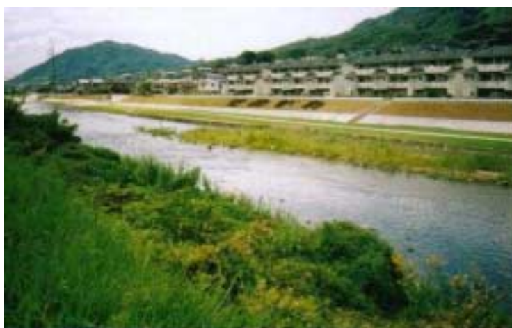
瀬野川河川環境整備事業（安芸区）
