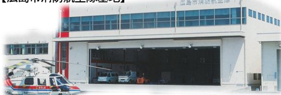
【広島市消防航空隊基地】
