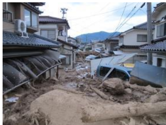
道路が土砂で埋め尽くされています
