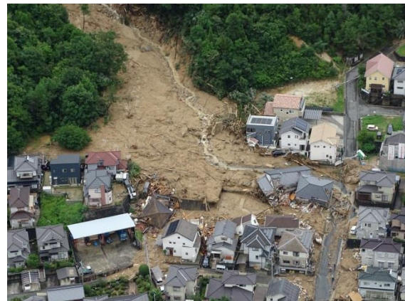
安芸郡熊野町川角五丁目の様子
