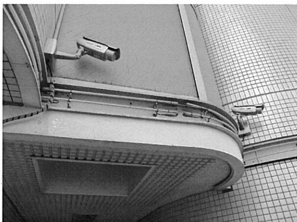
防犯カメラの設置 (薬研堀通り)
