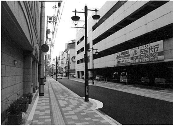
薬研堀通りの歩車道整備
