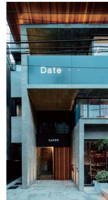
写真提供/足袋井 竜也 (足袋井写真事務所)
