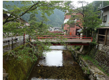
打尾谷川上流から見た湯来温泉
