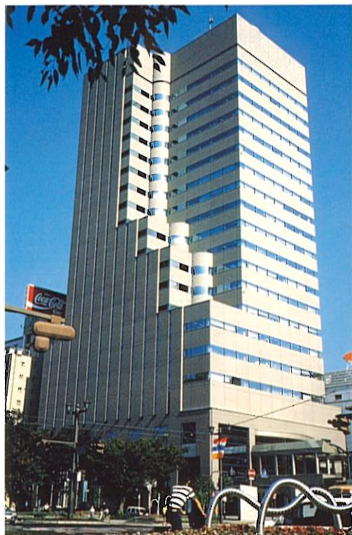
NHK 広島放送センタービル (建築物・工作物部門)
