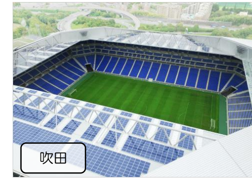
非常用電源（太陽光発電）
