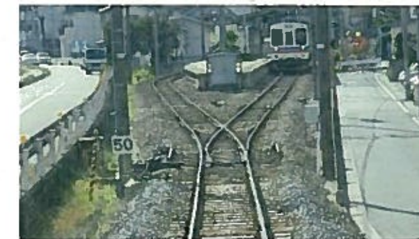
図 2-3 行き違い設備の例（三滝駅）
