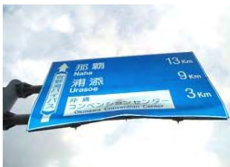
道路標識板の変状事例
