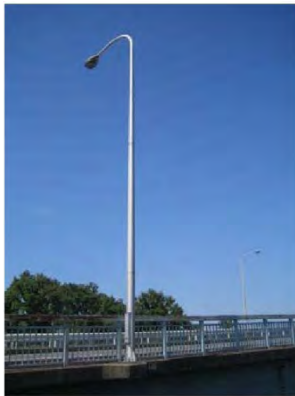
橋梁部に設置
