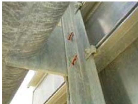
標識板取付部
