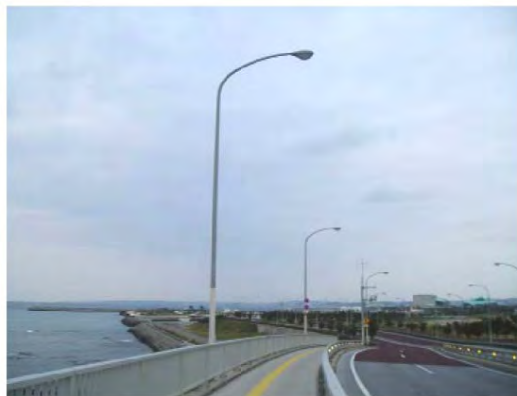
海岸付近に設置
