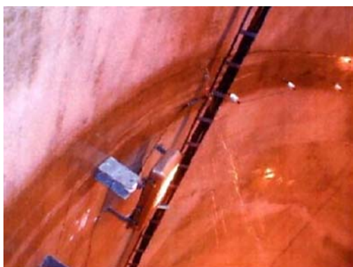
付写真 漏水（噴出）している例
