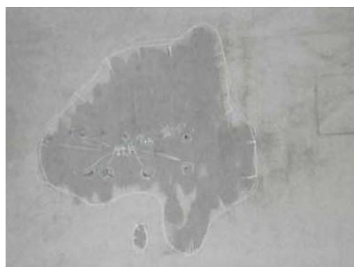
付写真 覆工コンクリートが変色している例 （うき・はく離を伴う）
