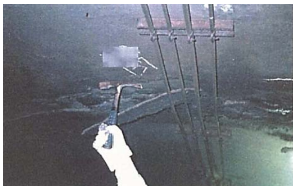
付写真 補修モルタルが劣化してはく離している例
