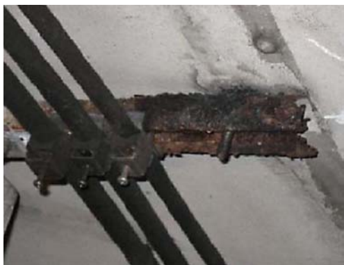
付写真 固定金具の腐食とアンカーボルトの脱落の例
