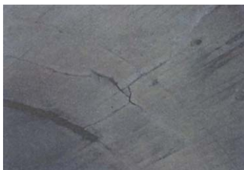
付写真 複数のひび割れで覆工コンクリートがブロック化している例
