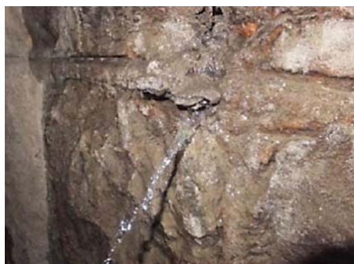
付写真 漏水（噴出）している例
