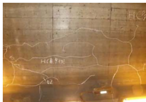
付写真 複数のひび割れで覆工コンクリートがブロック化している例
