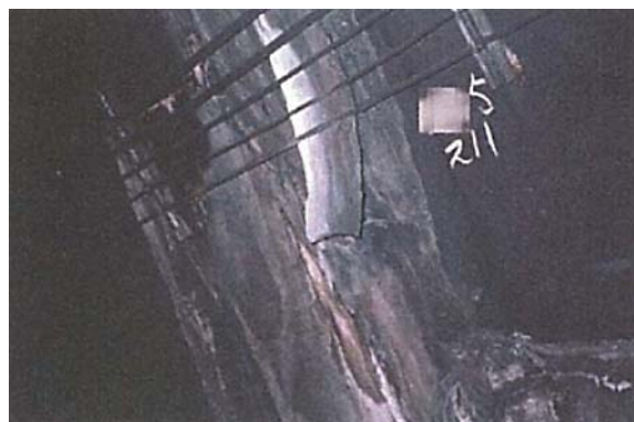
付写真 補修モルタルが劣化してはく離している例
