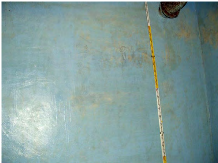
詳細6 虹山1号池 側壁
