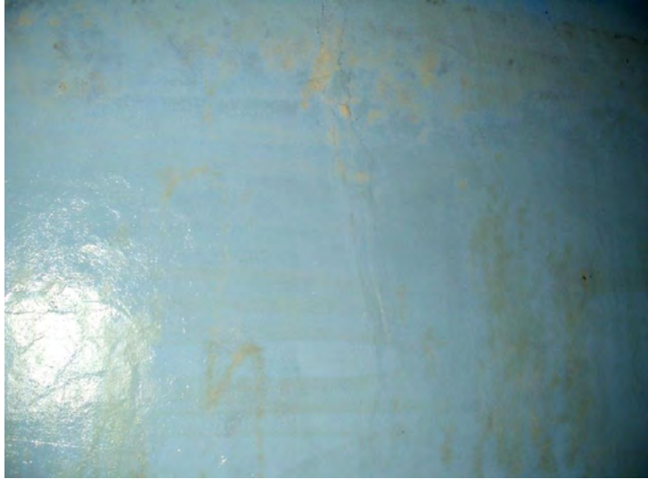
詳細7 虹山1号池 側壁
