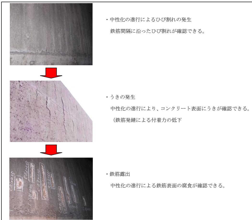
参考図 5-17 中性化による損傷例 (壁高欄)
