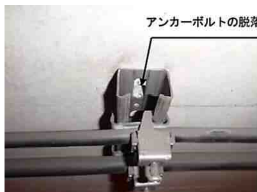
付写真 固定金具の腐食とアンカーボルトの脱落の例
