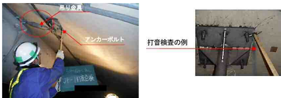
付写真 打音検査作業状況
