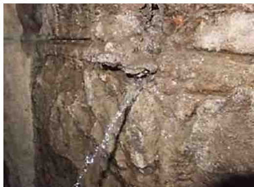
付写真 漏水（噴出）している例
