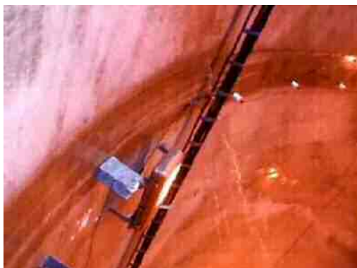
付写真 漏水（噴出）している例
