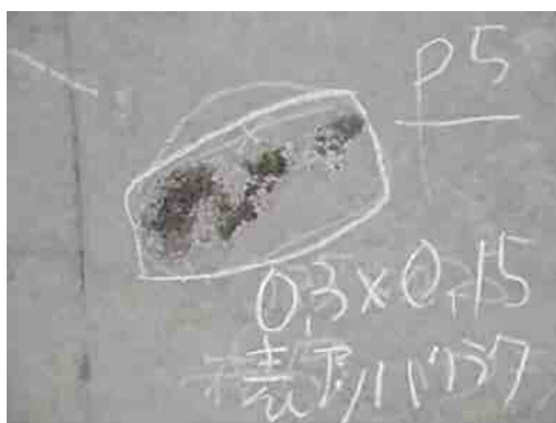
付写真 覆工コンクリートが変色している例 (うき・はく離を伴う)
