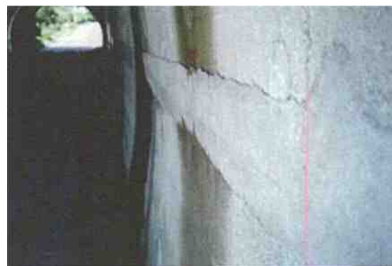
付写真 逆巻き工法の縦断方向打ち継目と化粧モルタルの施工状況の例
