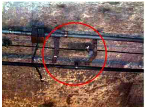
落下照明取付部の状況
