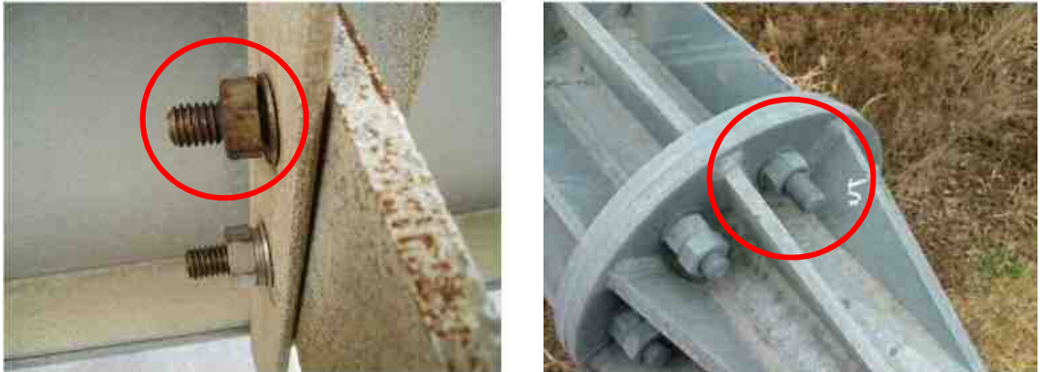
写真 8-9 設置後 10 年以内の附属物の変状事例
