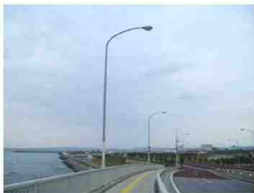
海岸付近に設置
