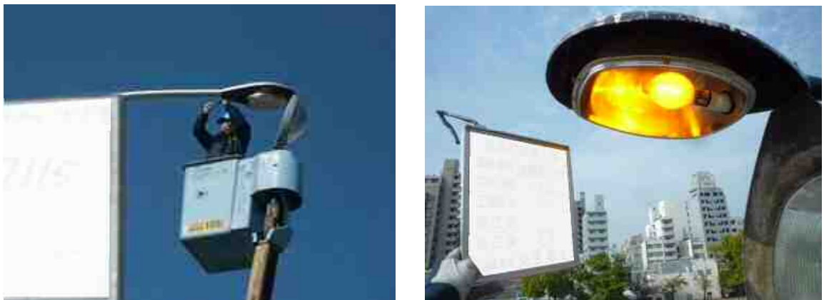
写真 8-10 高所作業車を使用したランプ交換作業
