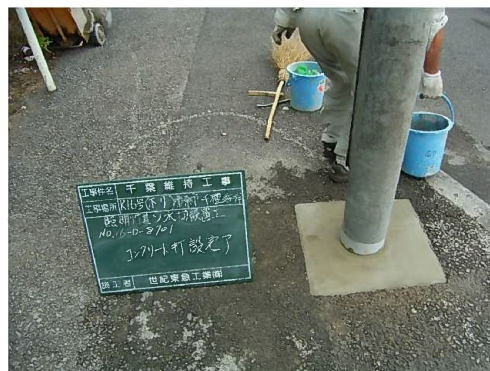
写真-解 12-1 水切りコンクリートの施工事例
