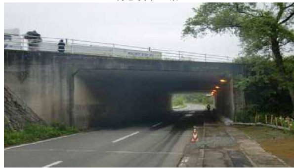
現地写真 全景
