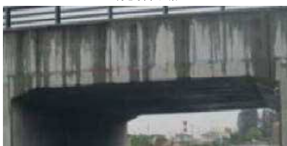
現地写真 近景
