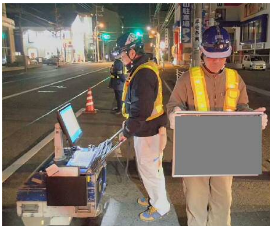
＜写真 5.2-2＞ハンディ型地中レーダ調査状況
