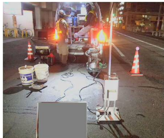
＜写真 5.2-3＞スコープ調査状況
