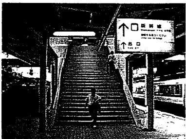
●一部を除き、各ホームへの昇降設備(エレベーター・エスカレーター)がなく階段のみである。
