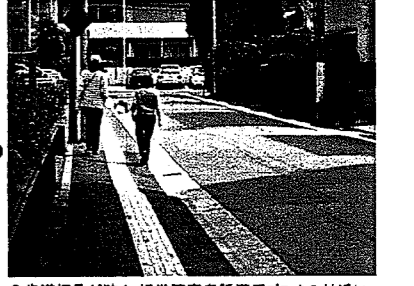
●歩道幅員が狭く、視覚障害者誘導用ブロックの付近に電柱等の障害物がある。 ●舗装材と敷設式の視覚障害者誘導用ブロックでは、表面の質感が似ており、識別しにくい。
