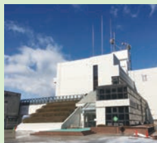
広島市総合防災センター
