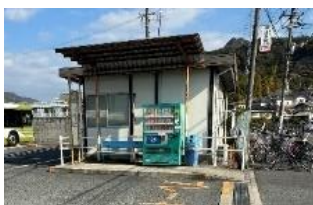
<老朽化した待合施設（郊外部）>
