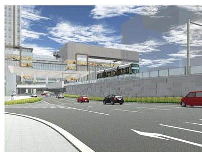
▲路面電車高架部（駅前大橋ルート）
