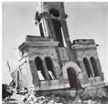
(撮影：川本俊雄 提供 / 川本祥雄) ▲爆風で傾いた時計店
