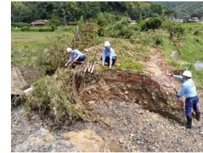
被災状況調査
