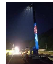
照明車による支援(鳥取県鳥取市)
