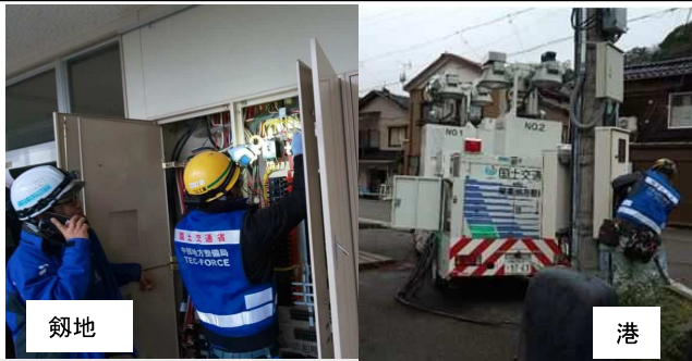
避難所への給電接続作業 (輪島市 劔地、浦上、道下、港)
