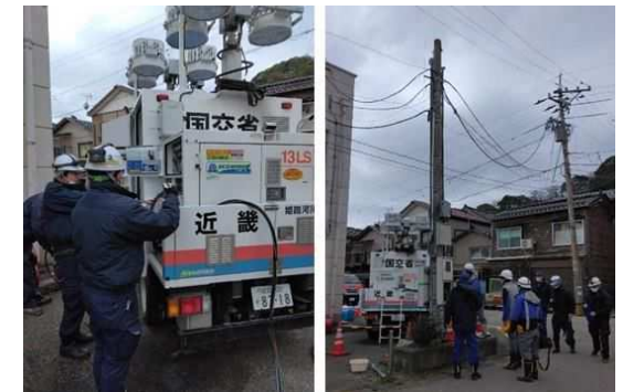
商用電源の通電で応急対応が完了 (輪島市 港公民館)
