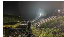
排水ポンプ車による排水作業(鳥取県倉吉市)
