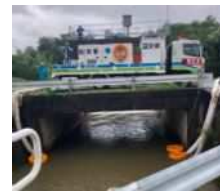
排水ポンプ車による排水作業(山口県山口市)
