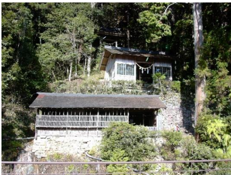
湯ノ山明神旧湯治場(本殿・拝殿・湯屋)
