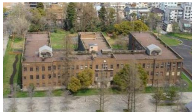
広島大学旧理学部1号館
