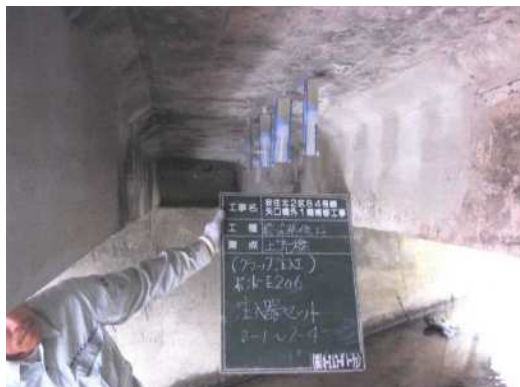
ひび割れ注入
