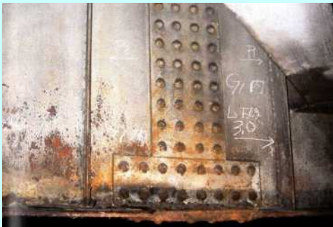
主桁の腐食
