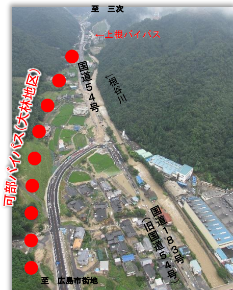
写真：平成26年8月20日豪雨災害時の国道54号の(下浜ヶ谷交差点付近)浸水状況
