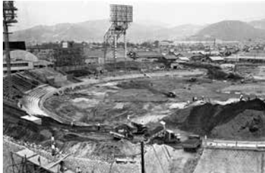
31 建設中の広島市民球場★ 昭和32 (1957) 年 6 月
