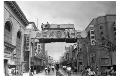
1 本通りアーチ看板設置作業★ 昭和34(1959)年
