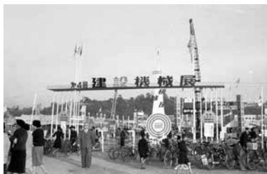
39 建設機械展★ 昭和32 (1957) 年 10 月
