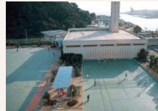
江波下水処理場 Eba Treatment Plant
