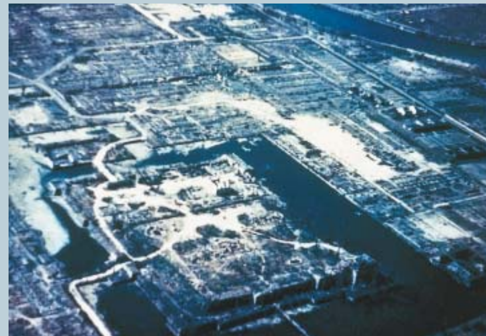
被爆後の広島城付近(昭和2年1月) The Same Area after the Atomic Bombing (October 1945)
