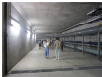
大州雨水貯留池の見学の様子
