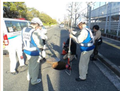
下水道BCP訓練
