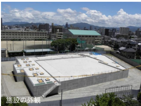
合流改善施設例 （江波雨水滞水池）
