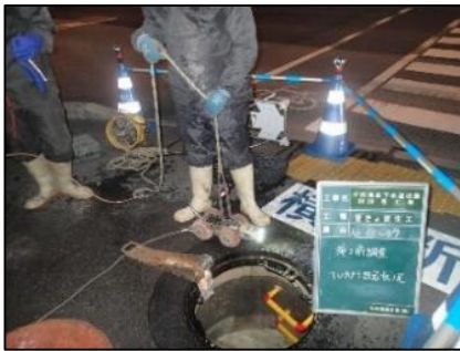
図表 5-Ⅳ 管路調査
