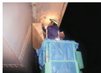
橋りょうの点検作業(アストラムライン)
