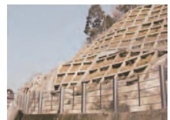
急傾斜地崩壊対策事業
