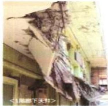
マンションの2階廊下部分が崩落した事例
