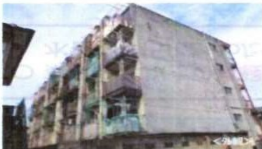
建物の傷みが著しく外壁の剥落、鉄骨の露出などが見られる事例
