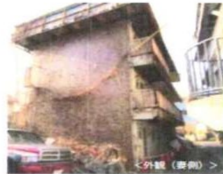
外壁、手すりが崩落した事例
