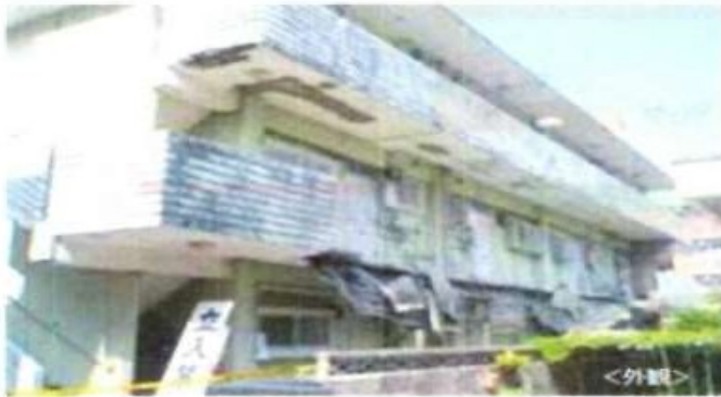
マンションの2階廊下部分が崩落した事例
