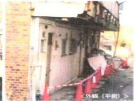
外壁、手すりが崩落した事例
