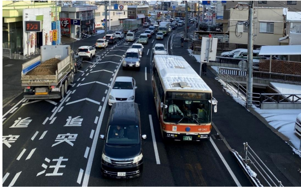
▲ 国道183号(祇園大橋北詰付近)
