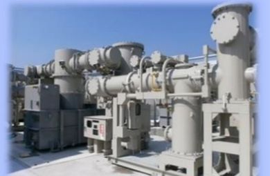
受変電設備取替工事
