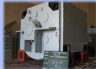
高尾取水場電動機分解補修工事
