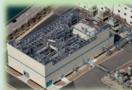
汚泥燃料化施設（西部水資源再生センター）
