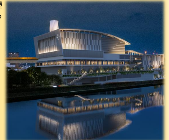
新南工場（令和10年度完成予定）
