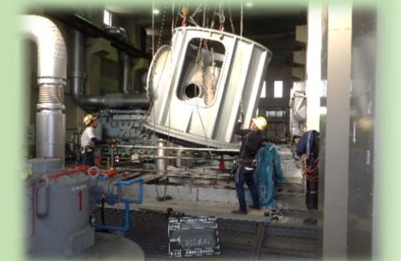
雨水ポンプ更新工事（庚午ポンプ場）
