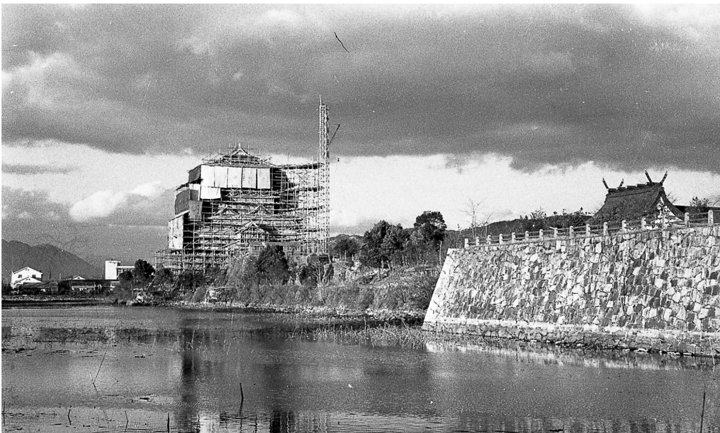
竣工直前の広島城天守 明田弘司氏撮影／広島市公文書館提供
