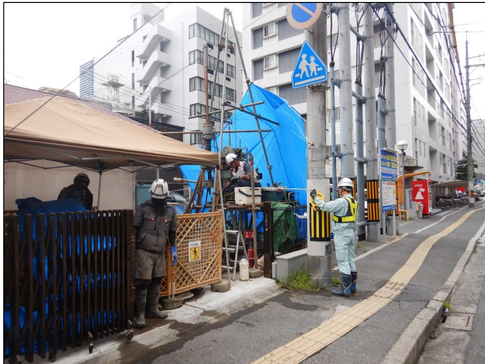
写真 電柱からの距離測定状況
