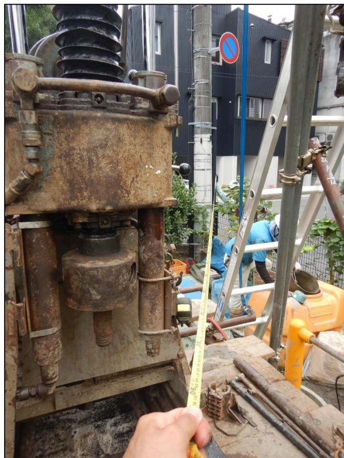
写真 電柱からの距離測定状況
