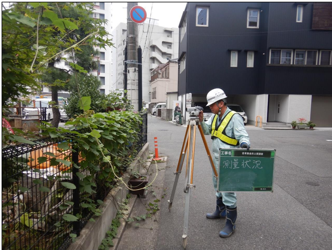
写真 水準測量状況
