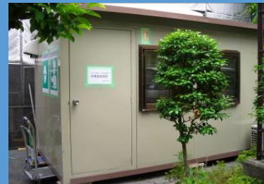
資材倉庫設置(例)
