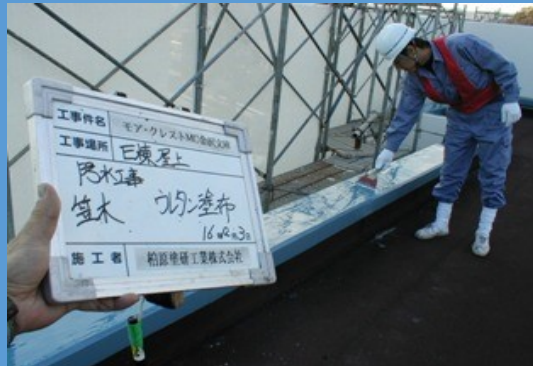
・笠木部ウレタン塗膜防水施工例
