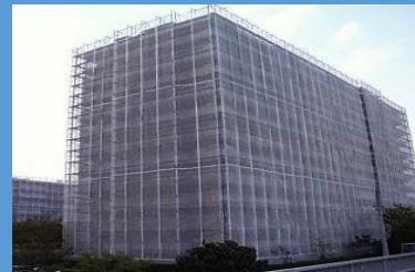
足場組立て完了例
