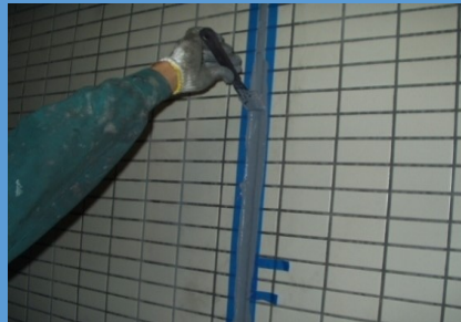
外壁目地施工例
