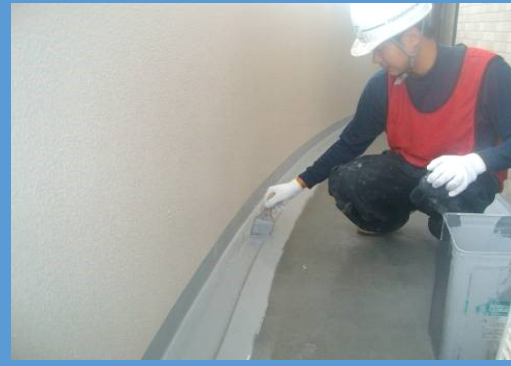
バルコニー側溝部防水施工例
