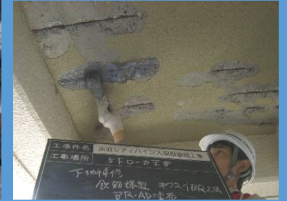
鉄筋爆裂補修施工例
