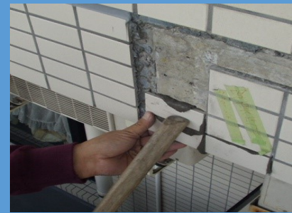
タイル貼替え補修施工例
