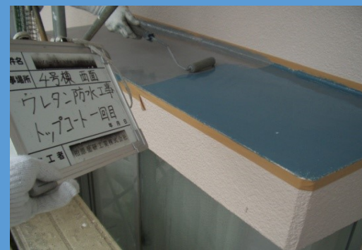
ウレタン塗膜防水施工例
