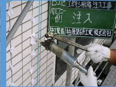
タイル浮き補修施工例
