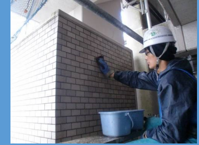
高圧水洗浄 施工例
