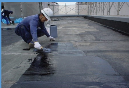
・改質アスファルト防水施工例
