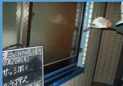
サッシ廻り施工例
