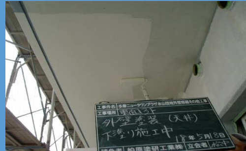
天井塗装施工例
