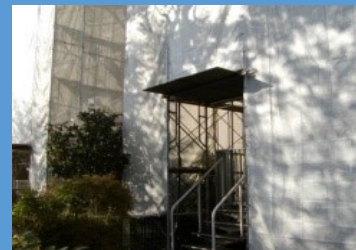
1階廻り出入口落下防止養生の例
