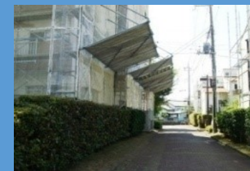
1階廻り出入口落下防止養生の例
