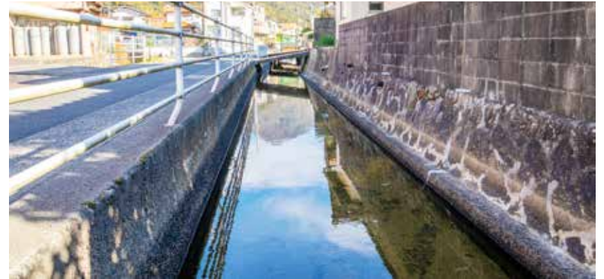
太田川発電所からの水を運び、田畑を潤しています
