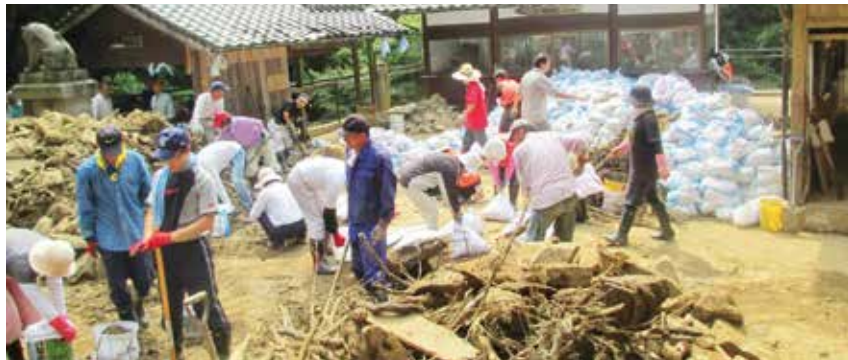
毘沙門堂の本堂前で土砂などの撤去作業（平成26年9月）
