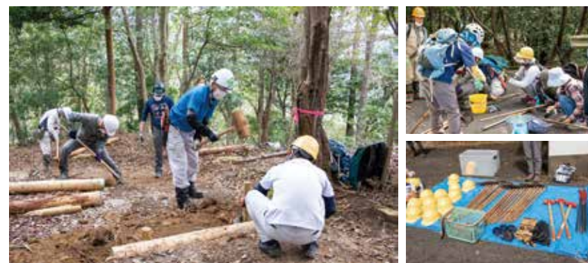
2か所に杭を打って留めます。作業が終わったら道具を洗って椿油を塗り手入れします
