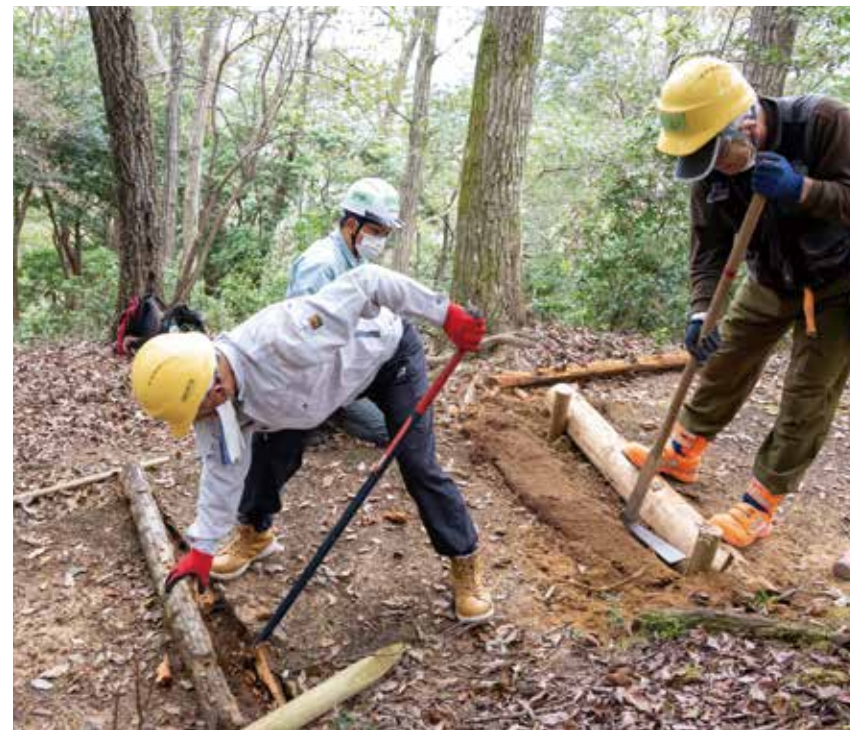
この日は、権現山林道脇の阿武山登山道入口から約200mの区間の丸太階段を整備しました
