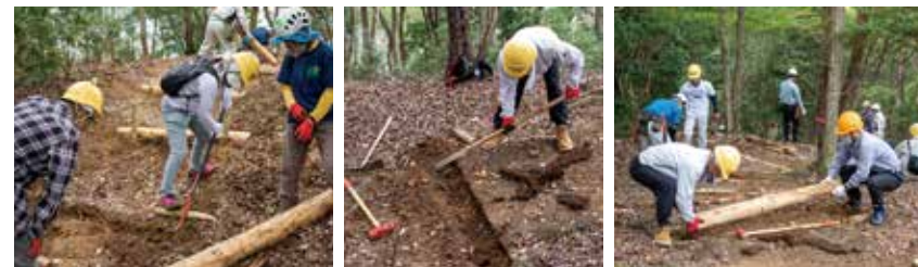
バールで古い横木やクギを撤去。溝を掘って新しい丸太を据えます
