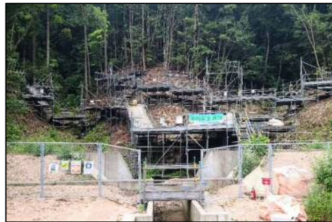
【南B・南C基準点I-2箇所の作業状況】
