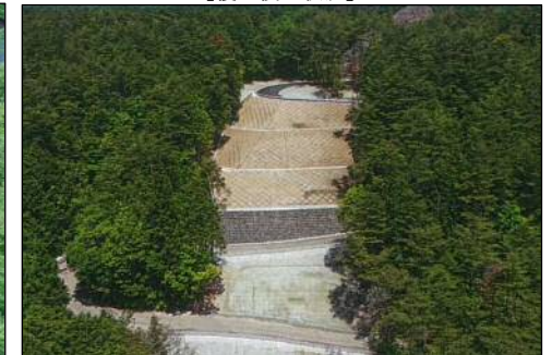
【復旧後の状況】
