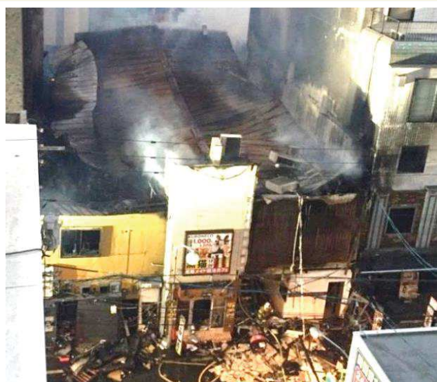
広島市中区流川町飲食店火災 (平成27年10月発生 3名死亡)
