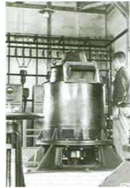
写真 1 新千田抽水所
