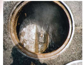
下水道管清掃状況
