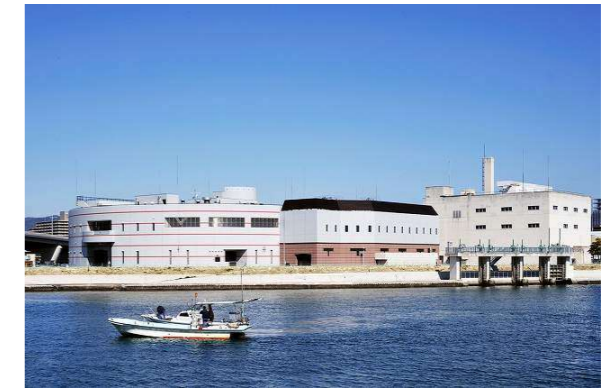
写真 4 新千田ポンプ場
