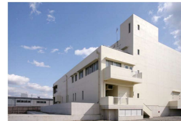
写真 3 西部臨海ポンプ場
