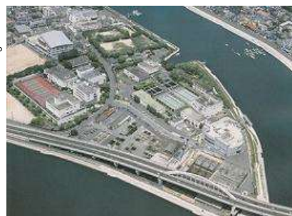
千田水資源再生センター
