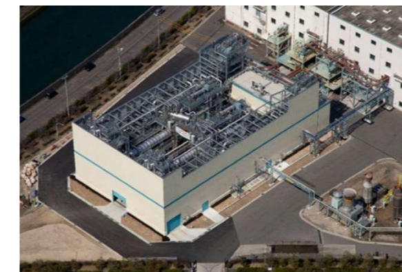
写真 5 西部水資源再生センター汚泥燃料化施設
