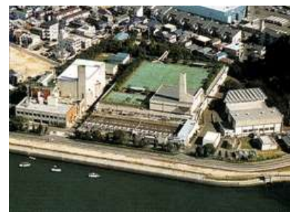
江波水資源再生センター
