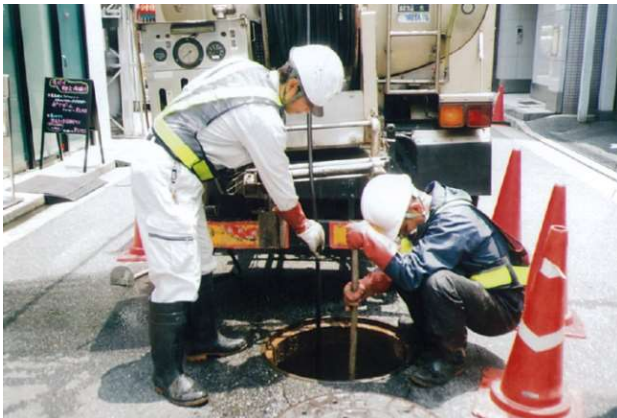
下水道管清掃状況
