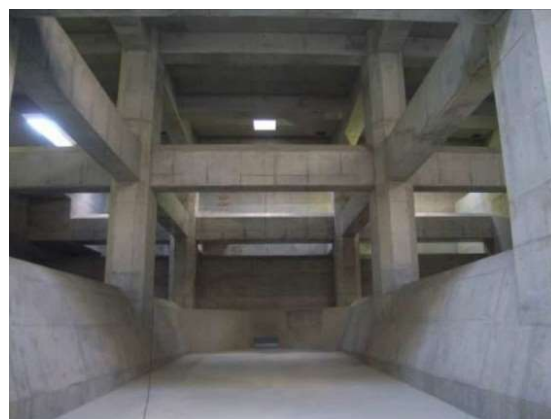
江波雨水滞水池（内部）
