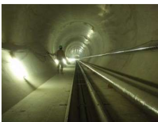
雨水幹線 (千田雨水1号幹線)
