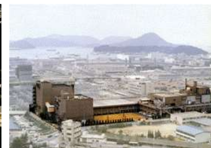
旭町水資源再生センター
