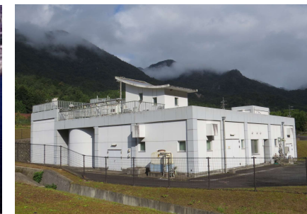
和田水資源再生センター
