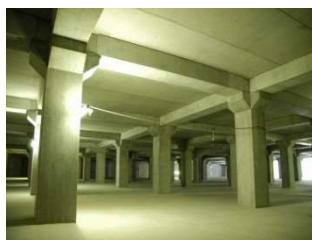
大州雨水貯留池
