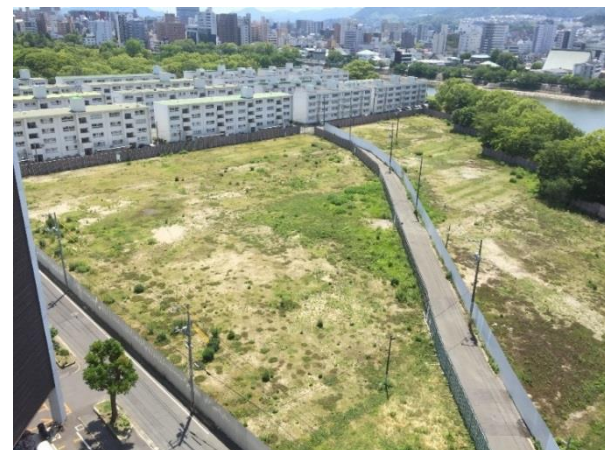
一部をオープンスペースとして暫定整備する県営基町住宅跡地
