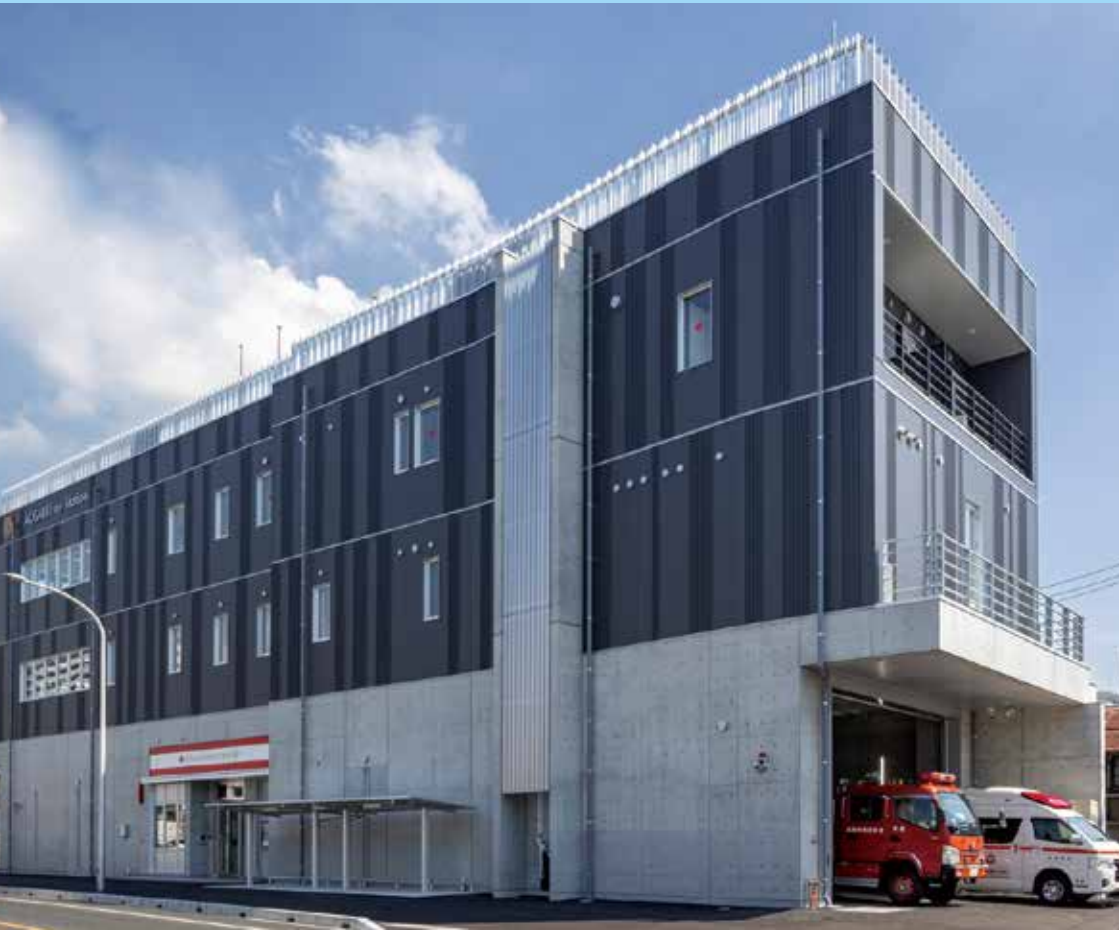
南消防署青崎出張所
